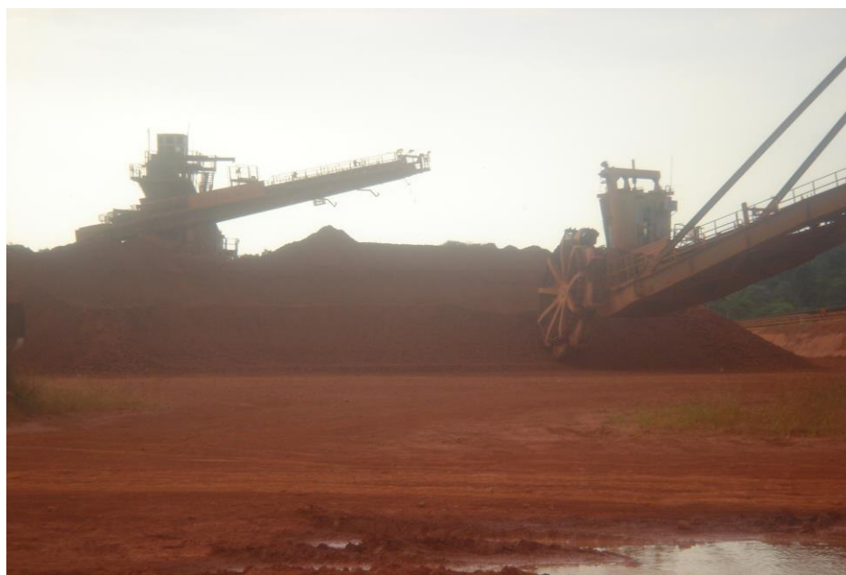
Figura 3 – Emissão de poeiras fugitivas provenientes da armazenagem e operações de manuseio da bauxita, fazem parte da poluição difusa, característica da inexistência do controle ambiental.
