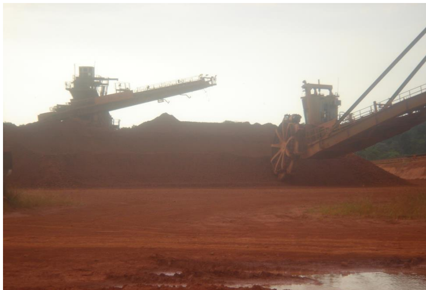
Figura 4 – Os Sistemas de transportes e pontos de transferência da bauxita (correia transportadora e elevadores de caneca) geralmente são dotados de Sistema de Ventilação Local Exaustora e Filtros de Tecido. Enclausuramento inadequado das correias transportadoras aéreas permitem o arraste, pela ação dos ventos, de particulados finos para atmosfera.
