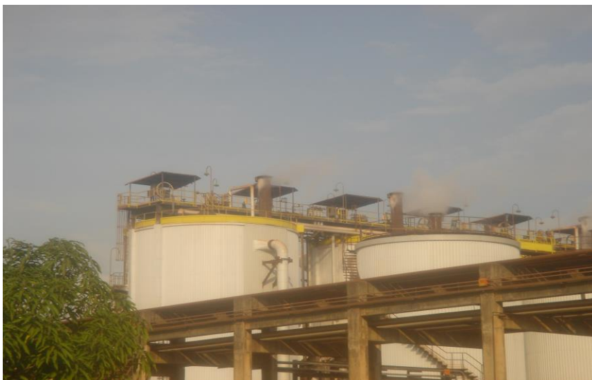
Figura 8 - A evaporação do licor cáustico, associada à inexistência de sistema de controle de poluentes, acarreta emissões atmosféricas em diversos pontos de armazenamento.
