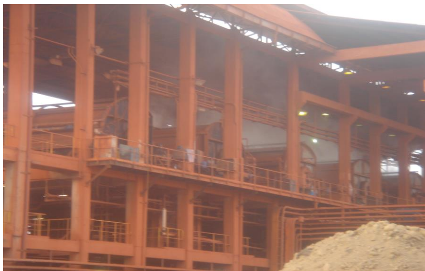
Figura 7 – A Unidade de Filtração da lama de bauxita, desprovida de sistema de controle de poluentes, apresenta emissões significativas de vapores cáusticos na atmosfera, colocando em risco o meio ambiente e à saúde dos trabalhadores.
