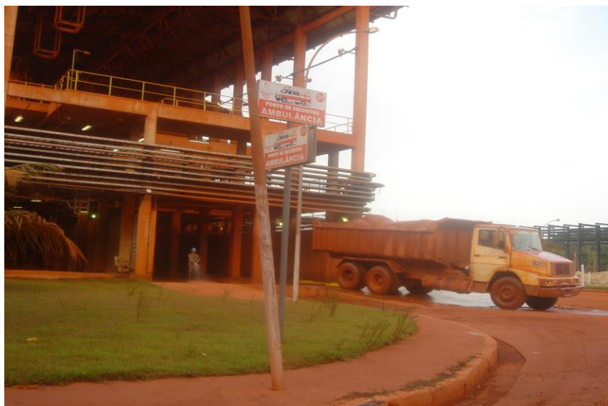
Figura 9 – O sistema de filtração de lama da bauxita, além de apresentar emissão significativa de vapores cáusticos, gera resíduos sólidos alcalinos. As operações de carregamento de caminhões e transferência dos resíduos geram efluentes líquidos contaminados. A fase mais crítica da contaminação ambiental ocorre no percurso entre a unidade de filtração e o local de disposição dos resíduos. A ausência de sistema de contenção de efluentes, aliada aos procedimentos operacionais de lavagem do piso da unidade tem potencial para poluir o solo, águas superficiais e subterrâneas.
